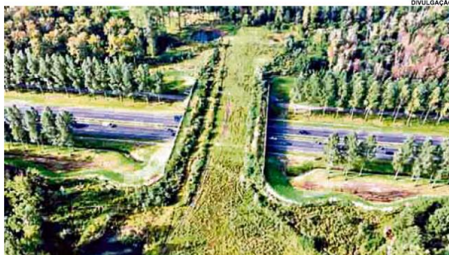
PASSAGENS VERDES possibilitarão transposições seguras da fauna ao longo da BR-101, principalmente no trecho entre a Reserva Biológica de Sooretama e a Reserva Natural Vale.
